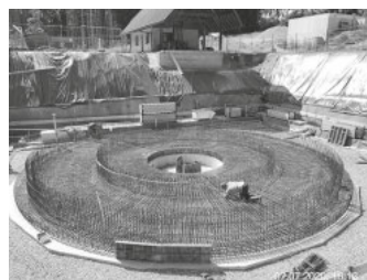
Bewehrung Bodenplatte Kombibecken Dichtigkeitsprüfung Kombibecken
